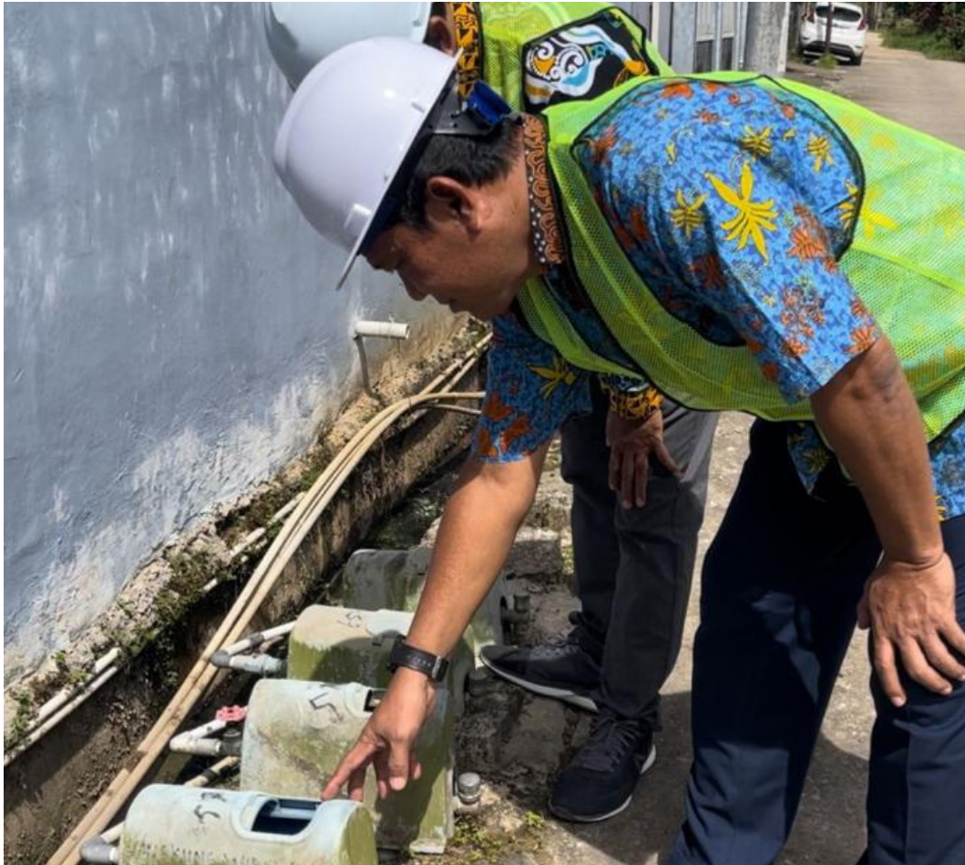
Perumda Air Minum Batiwakkal saat inspeksi lapangan ke rumah pelanggan. (Ist)
