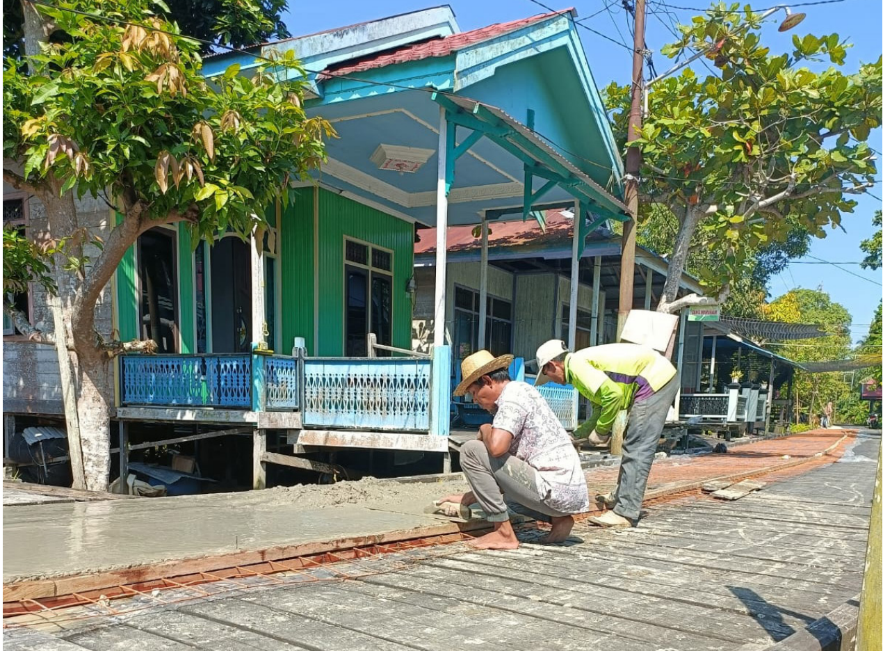
Peningkatan jalan dan jembatan di Kecamatan Muara Muntai. (Istimewa)
