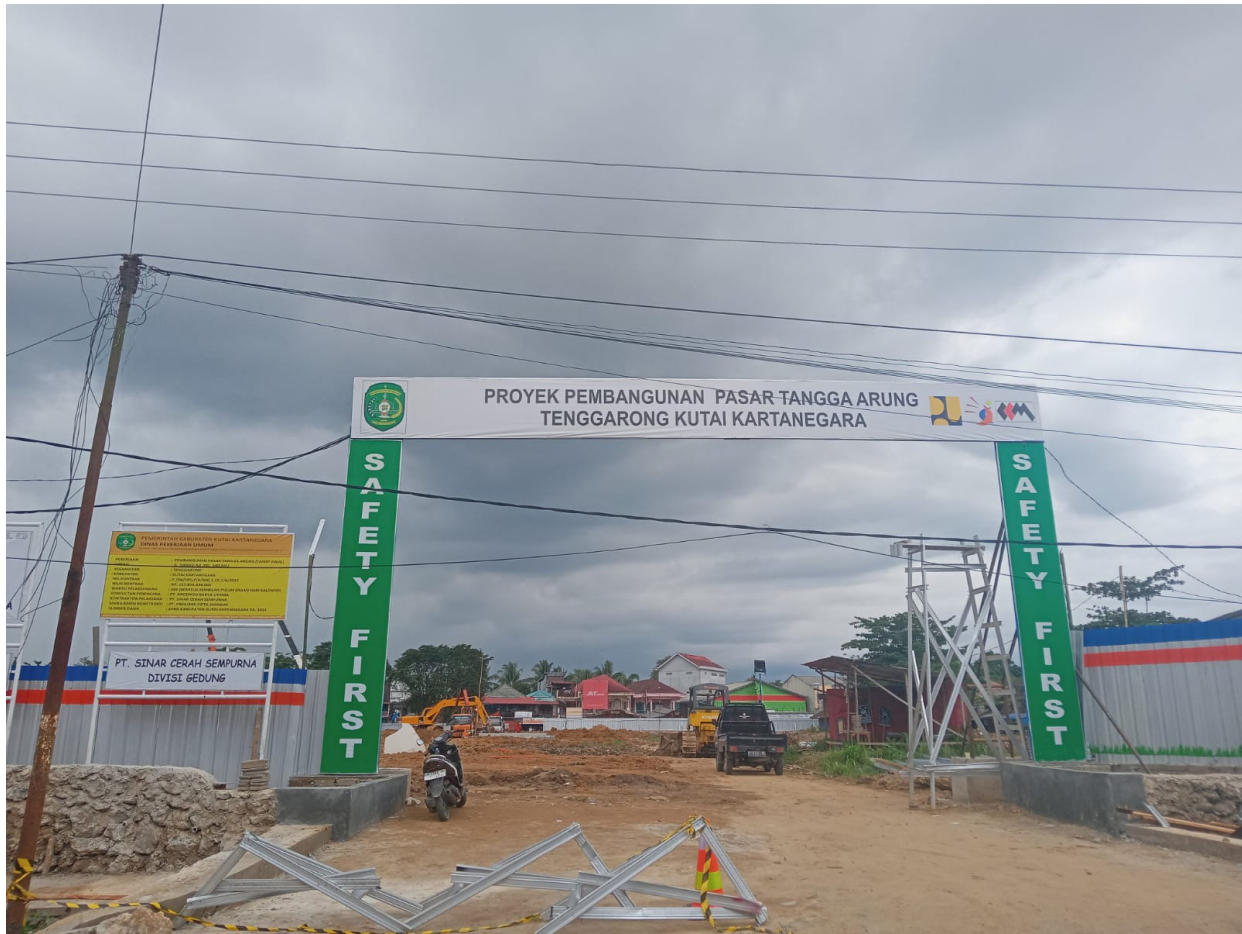
Proses Pembangunan Pasar Tangga Arung (Ady/Radar Kukar)
