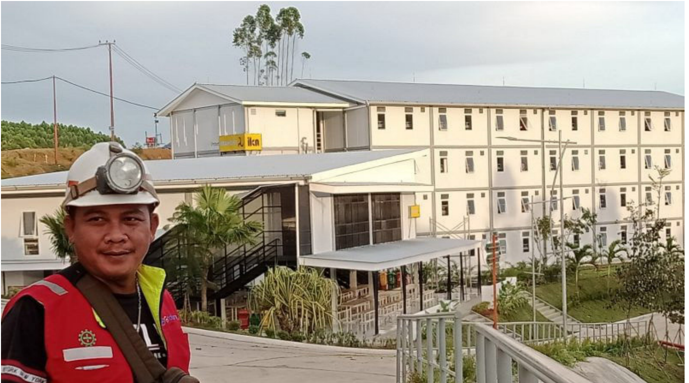
Hunian pekerja konstruksi (HPK) Ibu Kota Nusantara di Kecamatan Sepaku, Kabupaten Penajam Paser Utara, Provinsi Kalimantan Timur, salah satu sasaran pemeriksaan rutin malaria yang dilakukan Dinas Kesehatan setempat. ANTARA/Nyaman Bagus Purwaniawan
