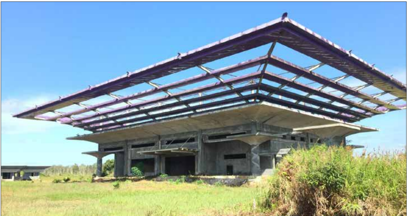
Kondisi pembangunan bandara
